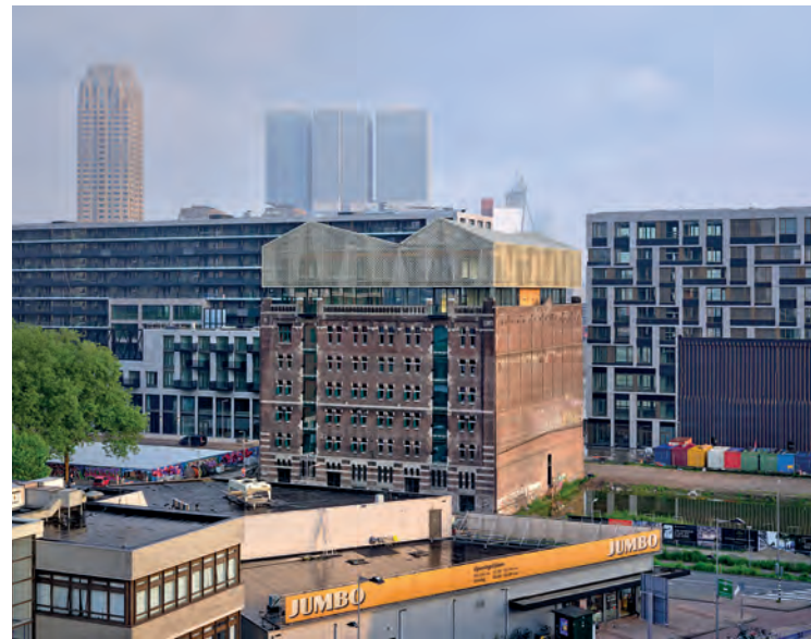
De tweede verdieping van de optopping heeft een siergevel van goudkleurige, geperforeerde gevelbekleding (foto: Studio Hans Wilschut).
