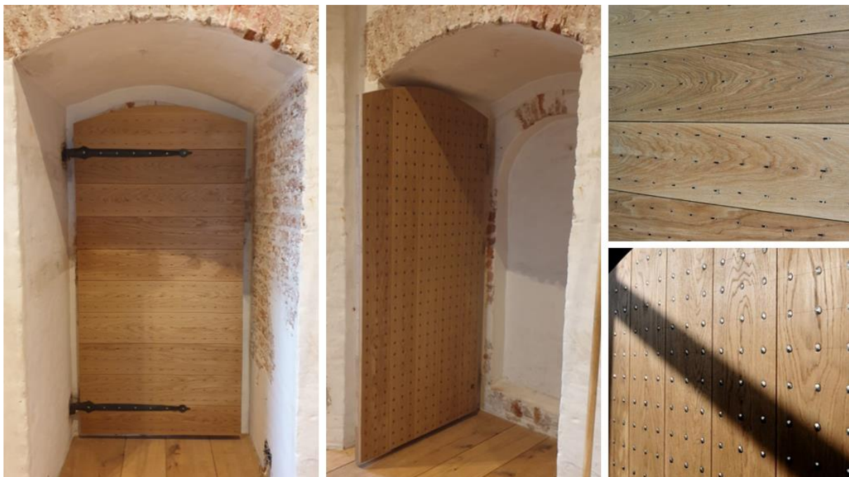
De nieuwe spijkerdeur in de nis met de oude, dichtgemetselde deursparing.
