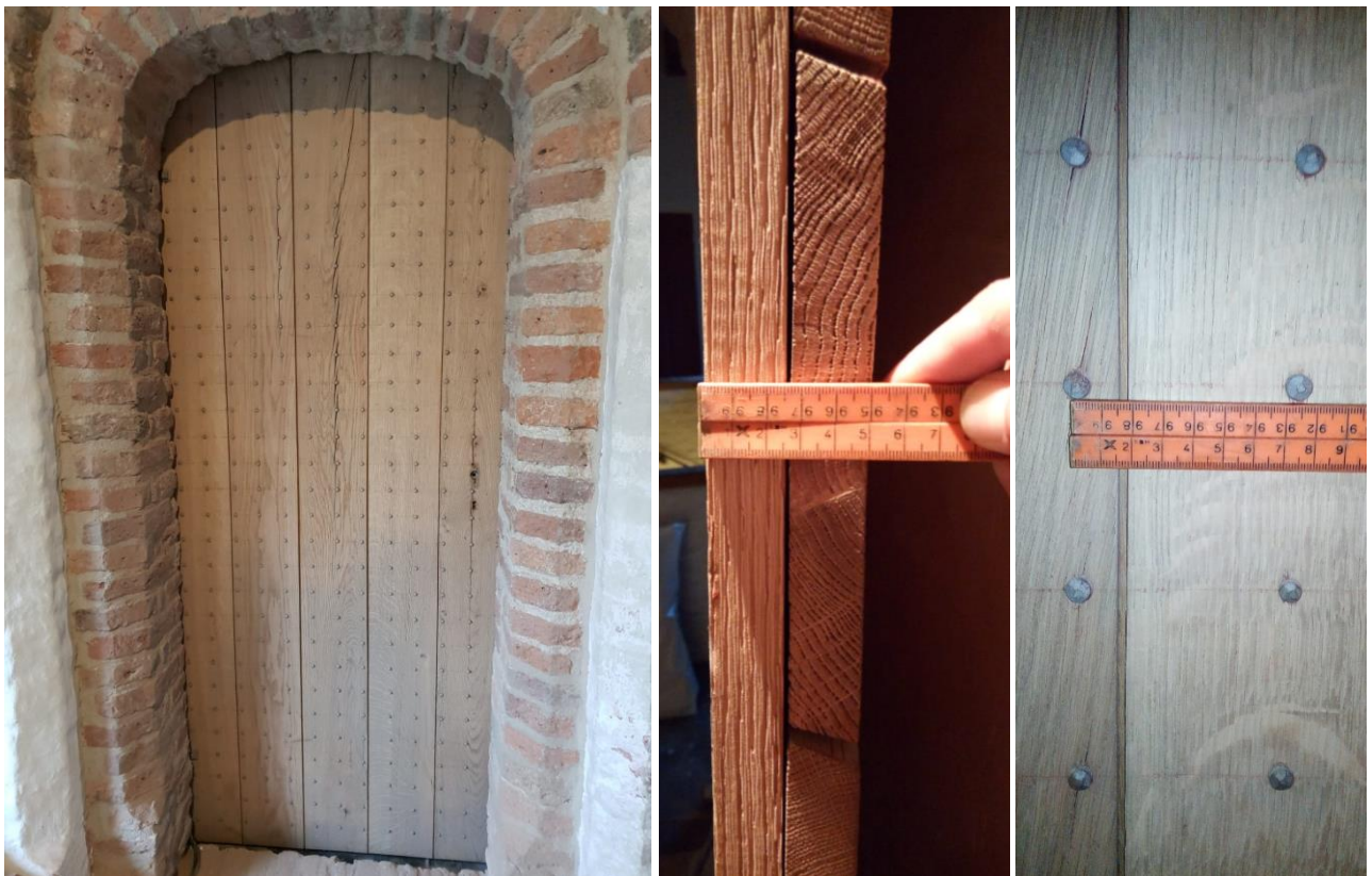
De originele spijkerdeur, waaraan de afmetingen van de delen en de afstanden tussen de spijkers afgelezen zijn.
