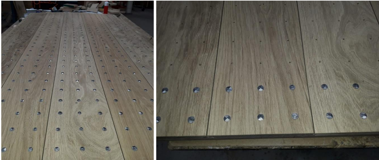
Rechts de voorgeboorde gaten. Links en rechts de plaatsing van de gesmede spijkers.
