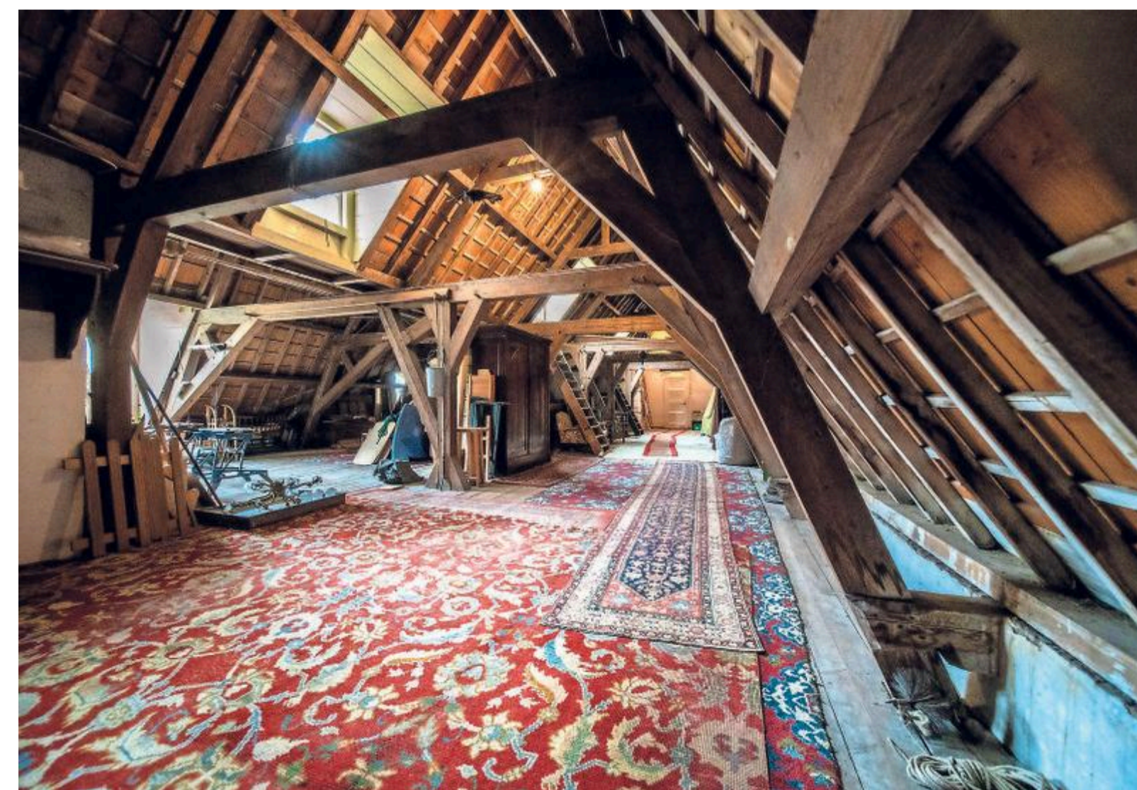
De zolder met zijn eeuwenoude balkenconstructie.
