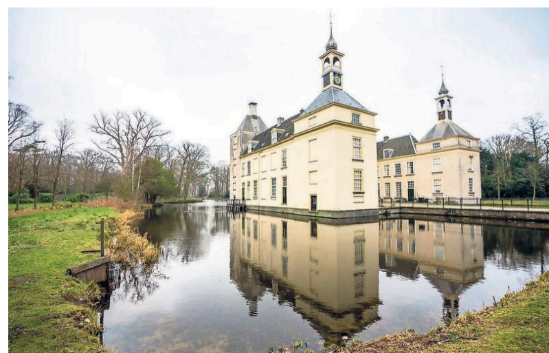
De al opgeknapte buitenkant van de westgevel.
