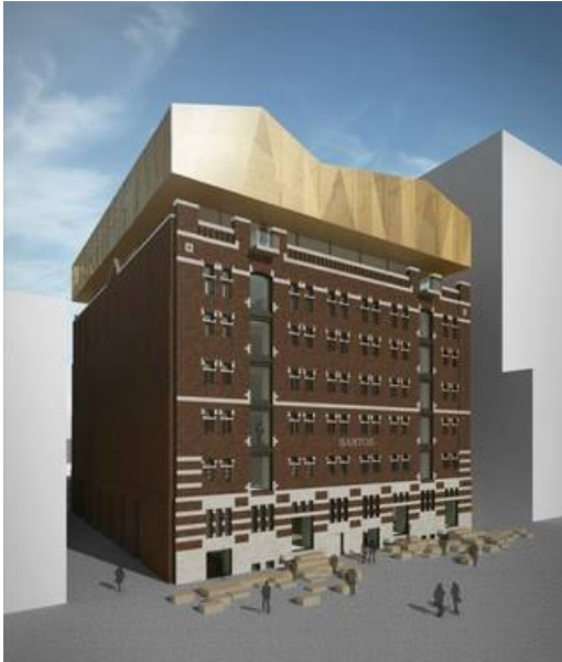
Impressie van pakhuis Santos met de twee extra verdiepingen en een 'kroon' op het dak. Renner Hainke Wirth Zirn Architecten en WDJArchitecten
